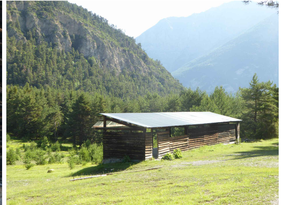
2. Prise de vue vers le stand de tir à démolir
