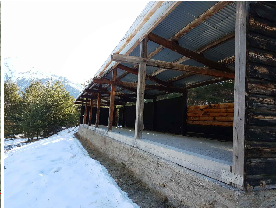
1. Prise de vue vers le stand de tir à démolir
